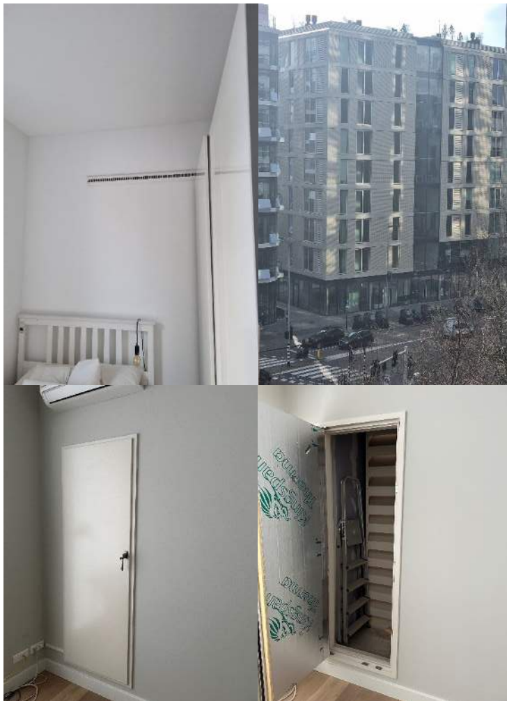
Figuur 12. Foto linksboven: verwijderd geluidrooster met teruggeplaatste ventilatiestrip. Foto's onder: geluidrooster in originele staat.
