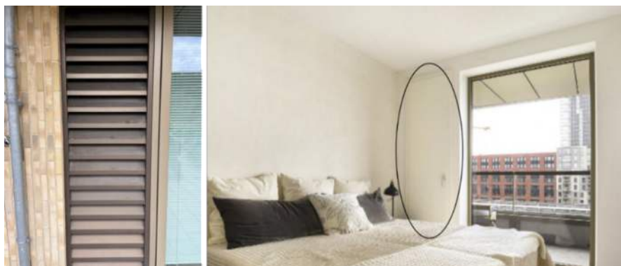
Figuur 1 _____ Geluidrooster op de Lindenhoeveweg in Amsterdam. In de slaapkamer is de deur naar het rooster omcirkeld.
