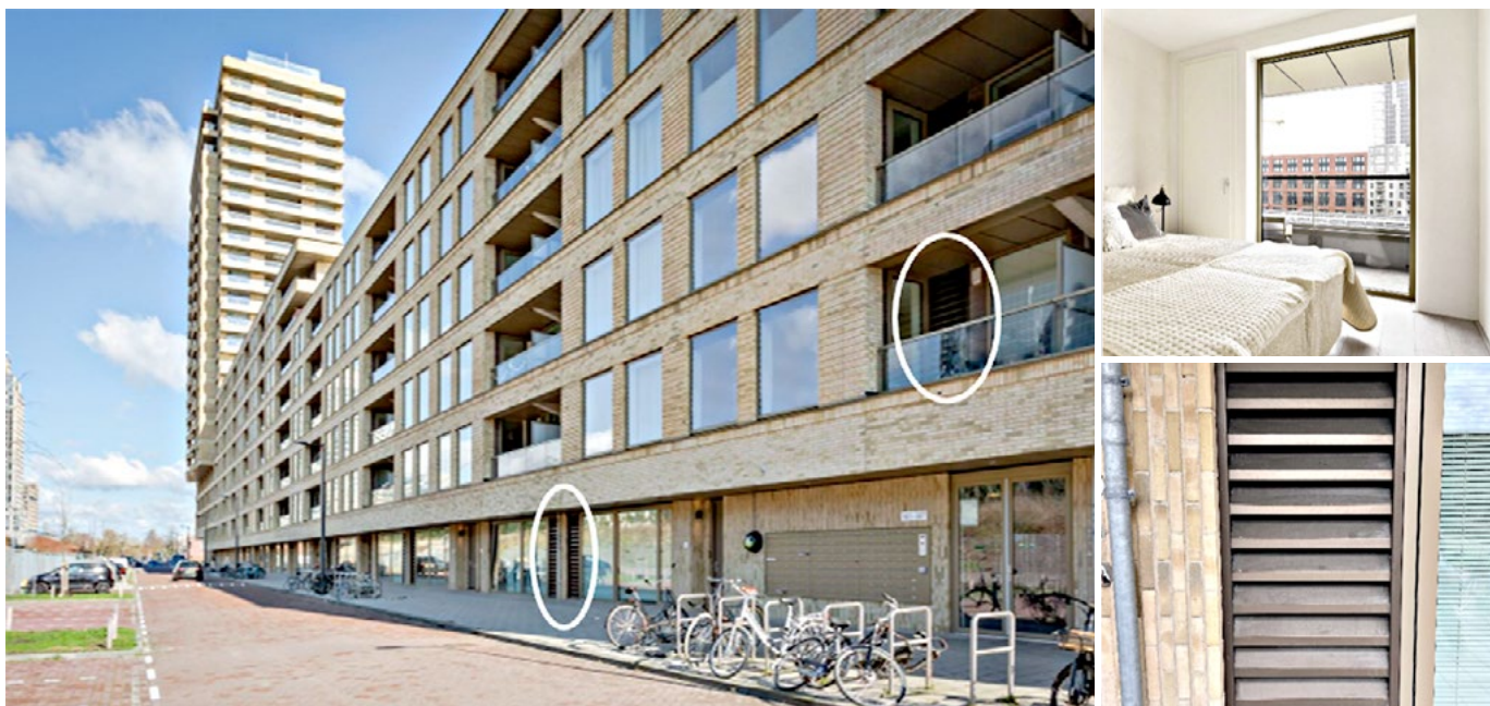
Figuur 1: Geluidroosters op de Lindenhoevenweg in Amsterdam. Linksachter in de slaapkamer is de deur naar het rooster.
